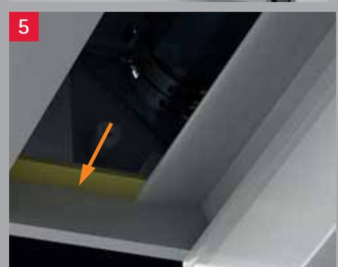
5. Appoggio laterale del celino migliorato con le strisce di nastro di tenuta autoadesivo.
