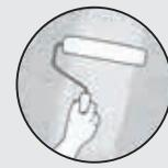
Lijar con lijadora y aplicar Triblock P hasta obtener una superficie perfectamente lisa y uniforme.
