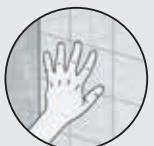
Die Homogenität der Oberfläche prüfen, bevor eine Schicht Mapewrap Primer 1\* auftragen.
