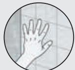
Comprobar la homogeneidad de la superficie antes de aplicar una capa de Mapewrap Primer<sup>1\*</sup>.
